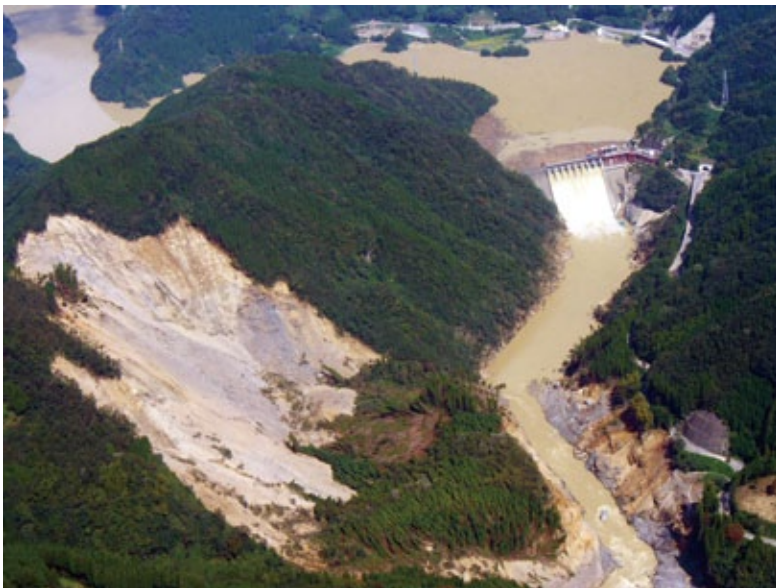
豪雨による山斜面の深層崩壊(提供:九州電力)
