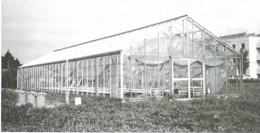
図 2-1-4 蓄熱式空気熱源ヒートポンプ（下段）とガラス室外観、内部状況
