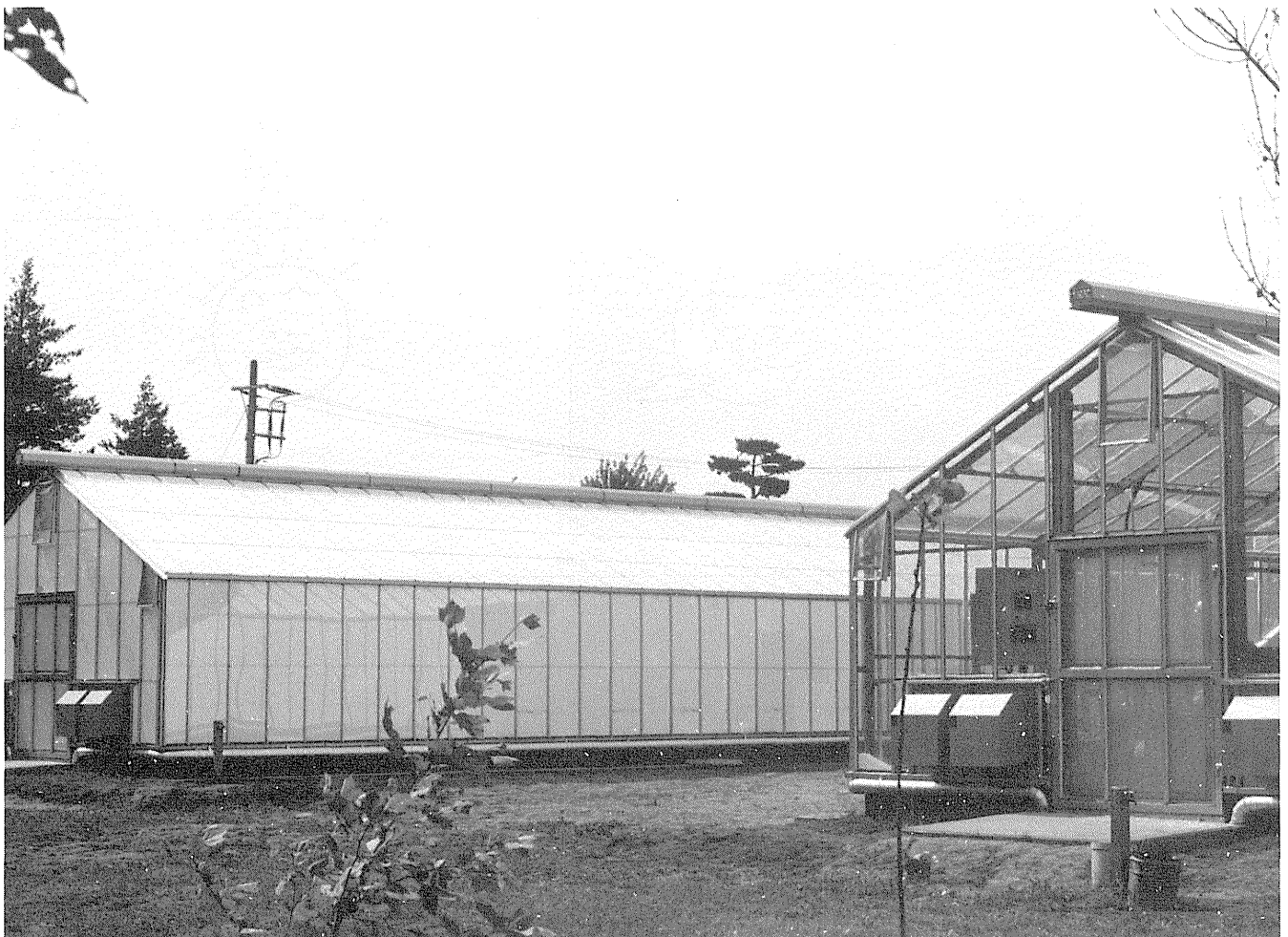
図 2-1-10 高能率野菜生産基礎実験設備の外観 （向側のハウスはペレット充填、手前のハウスはペレット排出状態）
