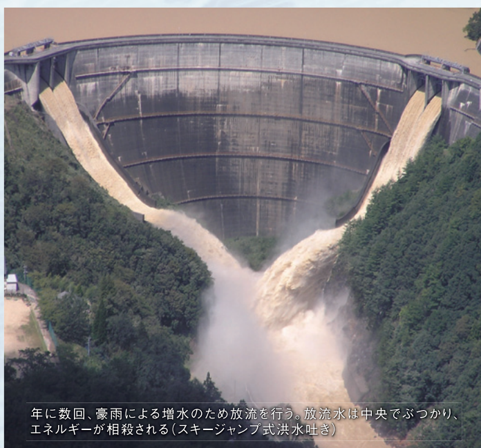
上椎葉ダム(宮崎県)は1952年に着工、1955年に完成した日本初のアーチ式コンクリートダム
