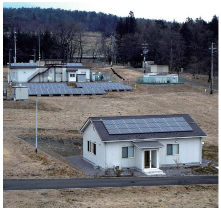
需要地系統実験設備(赤城試験センター)
