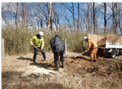
赤城試験センターの伐採樹木を利用したチップによる林道整備
