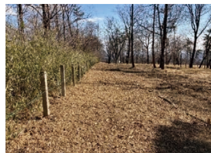
赤城試験センターの伐採樹木を利用したチップによる林道整備
