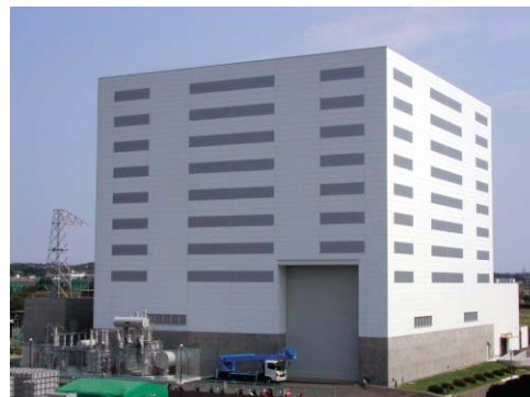
高電圧絶縁実験棟の外観
