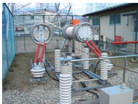
直流電圧発生回路
