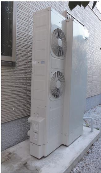
図1 フィールドテストを開始したコンパクトタイプエコキュート
