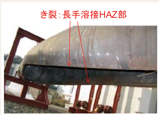
図5 破壊した9Cr鋼実機配管試験体の外観 (温度:650℃、破断時間:約8600時間)
