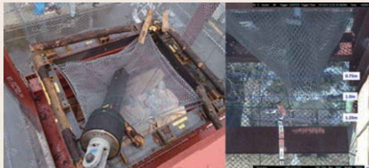
角型鋼管付き重錘の捕捉状況
