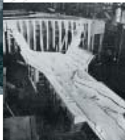
わが国初の本格的アーチダム・上椎葉ダム(上)と洪水吐け模型実験(右)(S29年ごろ)
