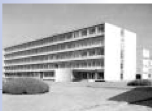
技術研究所の研究棟本館が竣工 (S32年9月)
