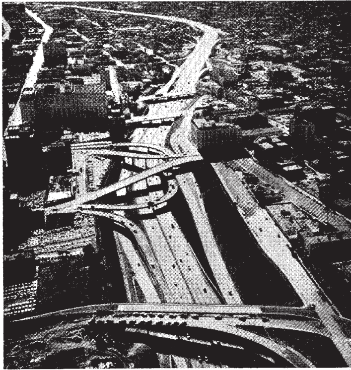
幾重にも立体交叉した高速道路 (アメリカ)
