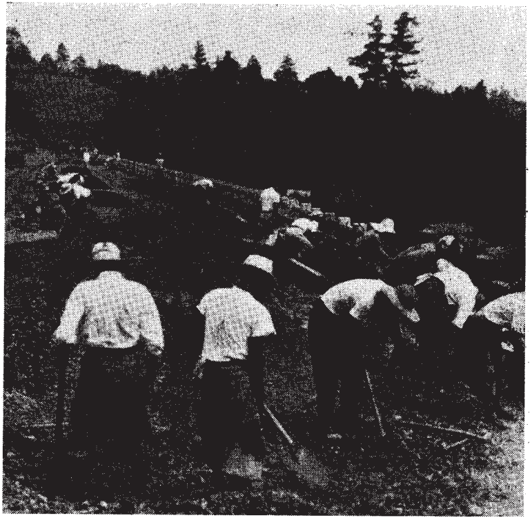
日本の道路工事の現状
