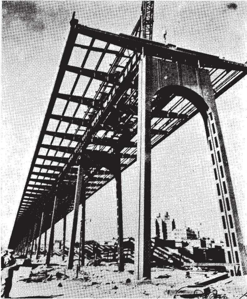
建設中の高架道路(アメリカ)
