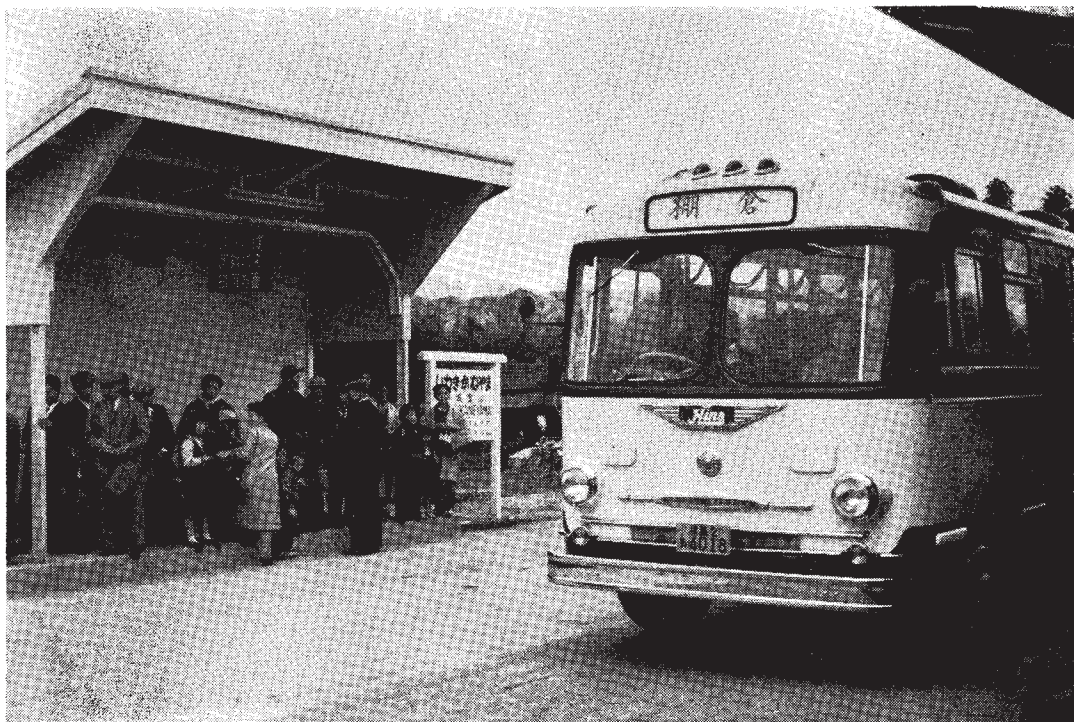
白棚線磐城金山駅、バスには珍しいホーム風景
