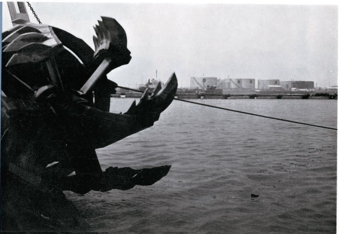
東京湾埋立地に建設中の重化学工場
