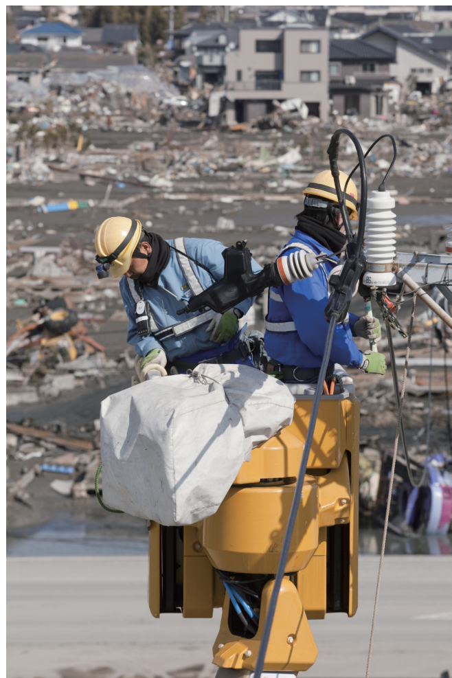
石巻市内での復旧作業 写真提供:東北電力
