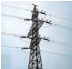
短絡電流遮断用アークホーンの取付け状況（図5）
