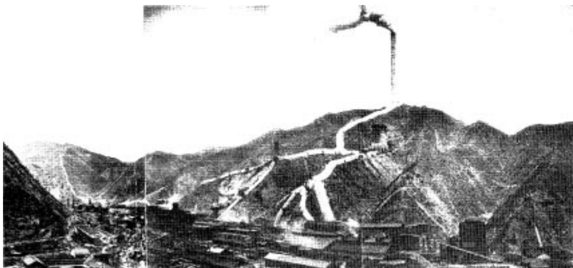
大煙突完成後の製錬所。谷間から煙は消えている(大正4年10月頃)
