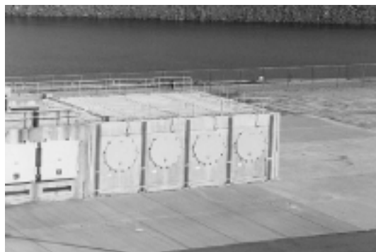
(横型コンクリートサイロ貯蔵施設：Ocone発電所)
