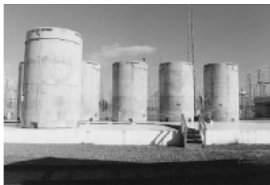
(コンクリートキャスク貯蔵施設：ANO発電所)
