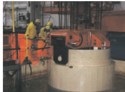
（プール内からのキャスク吊上げ）
