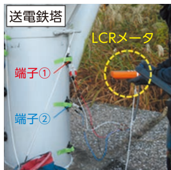
実際の送電用鉄塔での塗膜劣化診断の様子と赤城試験センターの大気ばく露試験設備
